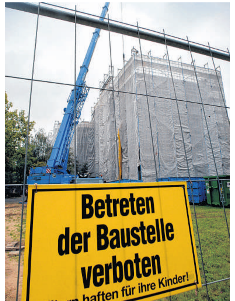
Baustelle Barkenberg (Betreten ist aber ausdrücklich erlaubt): Auch nach dem Stadtumbau steht der Ortsteil vor Herausforderungen. FOTO: LUTZ VON STAEGMANN
