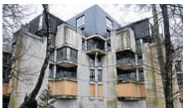
Das Habiflex-Gebäude steht seit fünf Jahren leer. FOTO: FM
